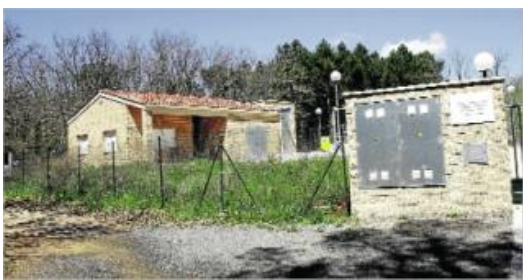
Instal·lacions de la depuradora Torrefortuna de Vidreres, que es repararà després dels desperfectes.
