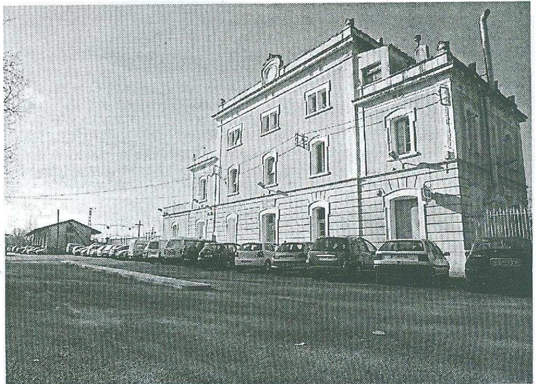
Vista exterior de l'edifici de l'estació de Caldes de Malavella. / MANELL Lladó.
