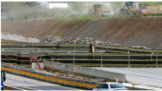
Les obres a l'enllaç de Sant Gregori. Foto: MANEL LLADÓ.
