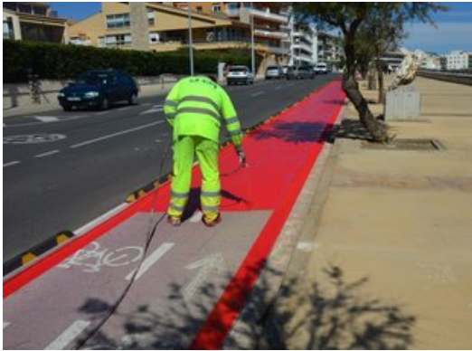
Un operari que pinta de color vermell el carril bici del passeig de l'Escala. Foto: EL PUNT AVUI.
