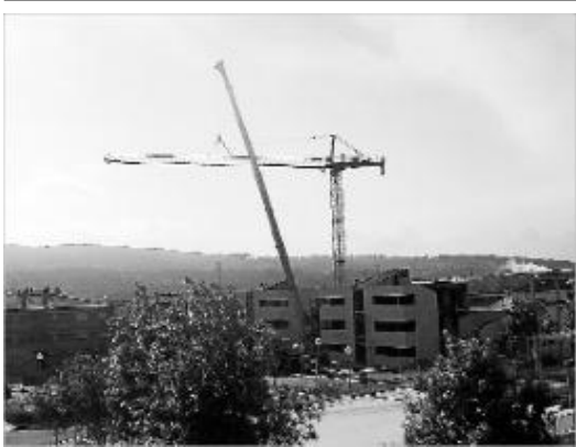
Un moment del desmuntatge de la grua, amb una altra grua.
