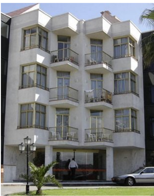
Els apartaments Bolero Park de Lloret de Mar extreta del seu web Foto: EL PUNT AVUI.
