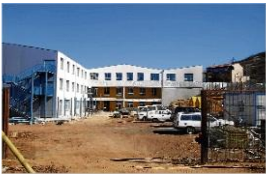
Estat actual de les obres del futur CEIP el Morrot.
