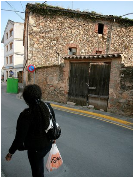
La casa afectada, amb la finca adjacent que els propietaris consideren que també s'ha d'expropiar. Foto: M. LLADÓ.
