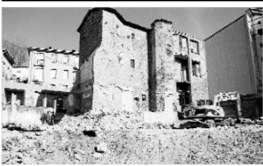
Obres d'enderroc de l'antiga fàbrica de Can Tané a Olot.
