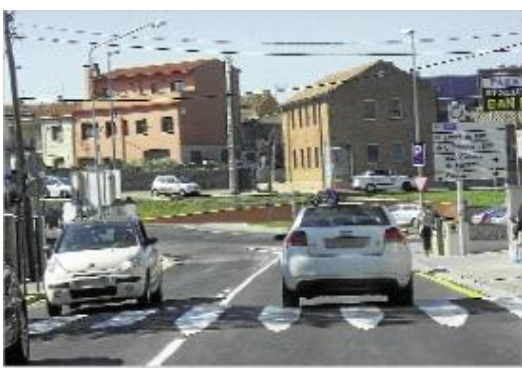
Vidreteres Nova imatge del carrer Costa Brava
