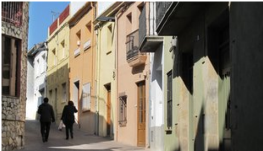
Algunes cases del carrer Sant Pere que han rehabilitat les façanes Foto: J.N.
