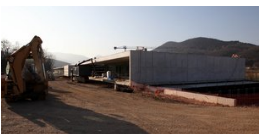
Les obres del nou hospital comarcal de la Garrotxa, a sota del Mas Subiràs, estan molt avançades a la part exterior. Foto: JOAN SABATER.
