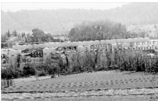
L'estructura del nou Hospital d'Olot ja està acabada i es preveu que entri en servei al 2013.
