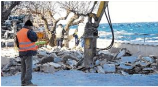
Els operaris treballant en la reforma de l'espai, malmès per l'efecte de la sal. <br/>
