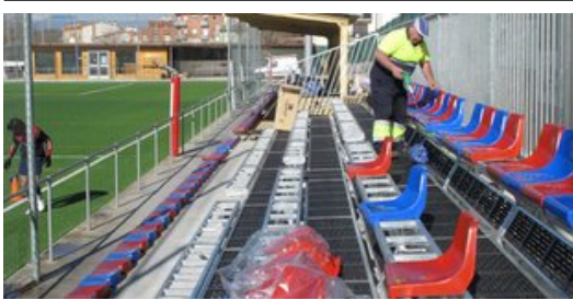
Els treballs d'instal·lació de les grades s'han fet al llarg d'aquesta setmana Foto: J.N.
