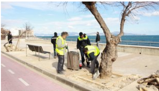
Els tècnics de l'empresa constructora analitzaven ahir el paviment del passeig de l'Escala. Foto: JOAN PUNTÍ.
