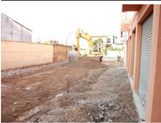
El carrer Pau Casals de Sant Pere Pescador, obert, i en plena remodelació. Foto: JOAN PUNTÍ.
