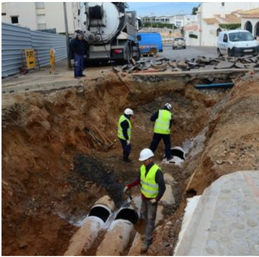
Les canonades de la depuradora a l'Escala, amb el carrer esbudellat. Foto: EL PUNT AVUI.
