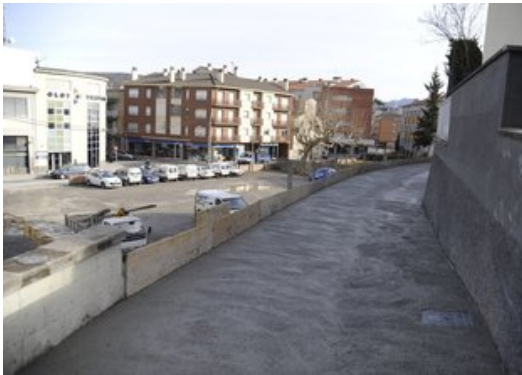
El tram en obres.
