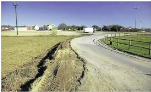
La zona de Vilobí que s'està convertint en un nou vial.<br/>
