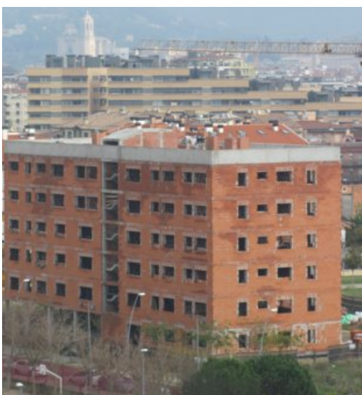
Nous habitatges en fase de construcció a Girona Foto: DANI VILÀ.
