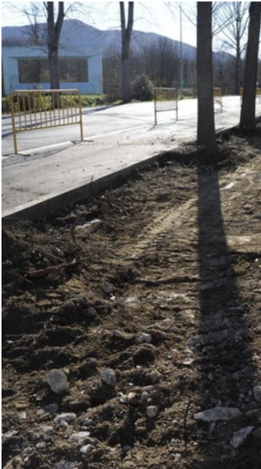
La vorera del Vial Sant Jordi, en obres. Foto: EL PUNT.
