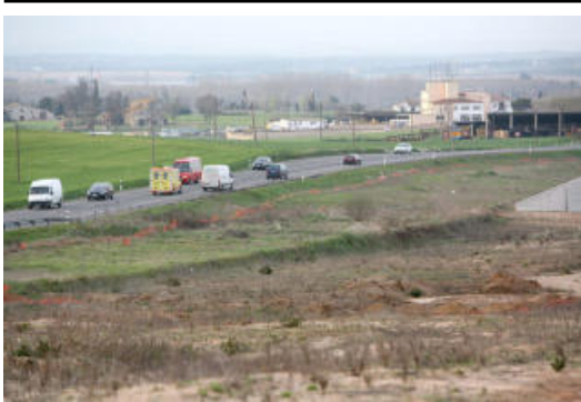
Les obres de desdoblament de la N-II entre Sils i Maçanet estan aturades des de l'octubre del 2008. <br/>
