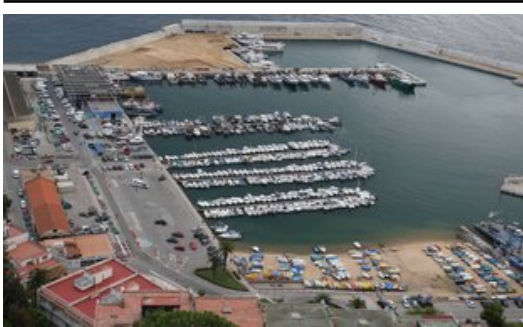
Una imatge del port de Blanes, on ja s'han acabat gairebé totes les obres. Foto: LLUÍS SERRAT.
