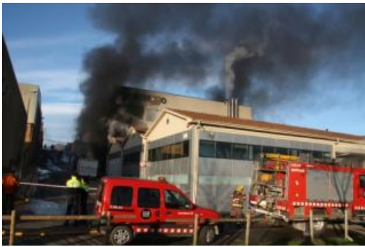
La fàbrica de maniquins Atrezzo a Olot crema des de la una de la matinada | ACN
