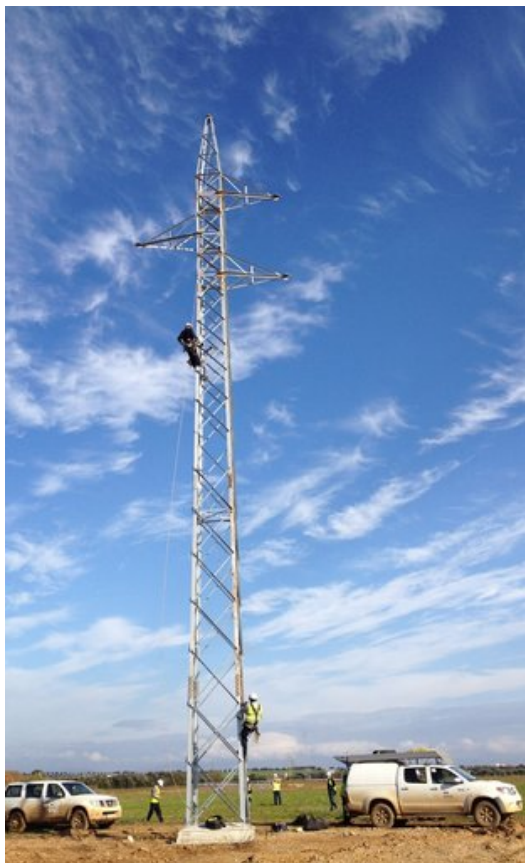
Operaris d'Endesa posant una de les torres de la nova línia elèctrica, a Vilafant.
