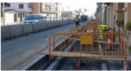
L'antiga travessera de la N-150 ahir al matí, en plenes obres de reurbanització. Foto: R. E.
