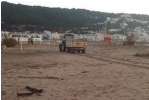
Les dues retroexcavadores i el tractor, ahir al matí . Foto: A.V.
