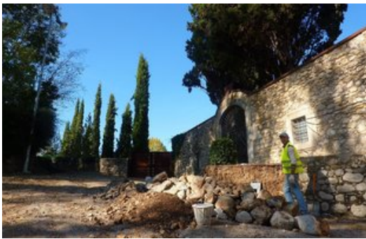
Les obres a la vora del cementiri, ahir al migdia. Foto: R. E.
