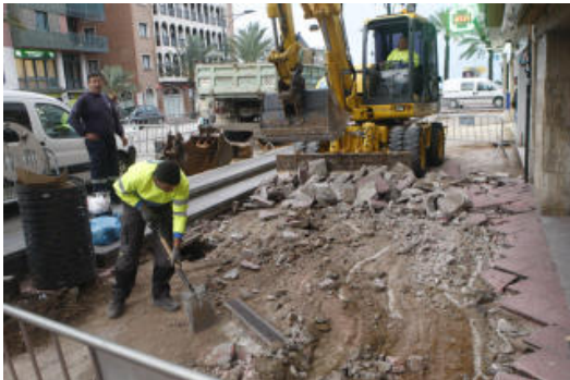
Les màquines, treballant pel canvi de paviment de la vorera.<br/>
