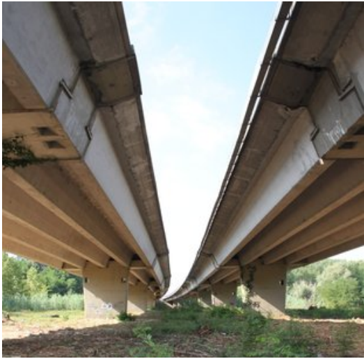
Una imatge d'arxiu de l'autopista AP-7, al pas per Salt. El gasoducte hi passarà a prop. Foto: JORDI NADAL.
