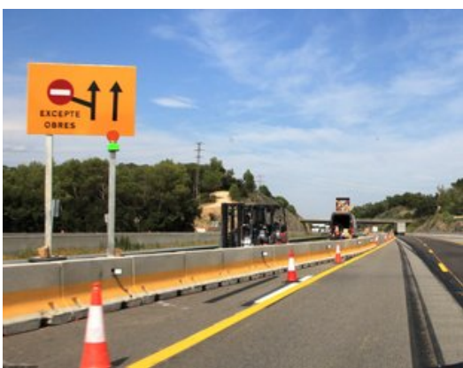
Les obres que s'estan fent a la circumval·lació de Girona de l'autopista. Foto: JOAN SABATER.
