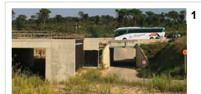
Estat de les obres de l'N-II entre Sils i Caldes, amb trams a mig construir des de fa dos anys. Foto: MANEL LLADÓ.
