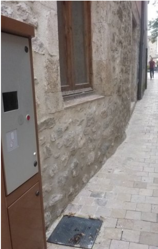
Un dels aparells ja instal·lats per restringir el pas al centre Foto: R. E.
