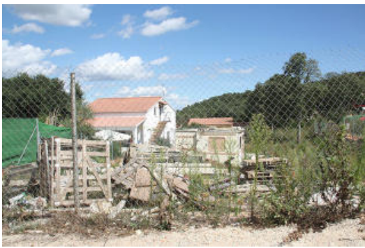
Les obres de millora s'han aturat a la urbanització Font Bona de Llagostera per alguns impagaments.
