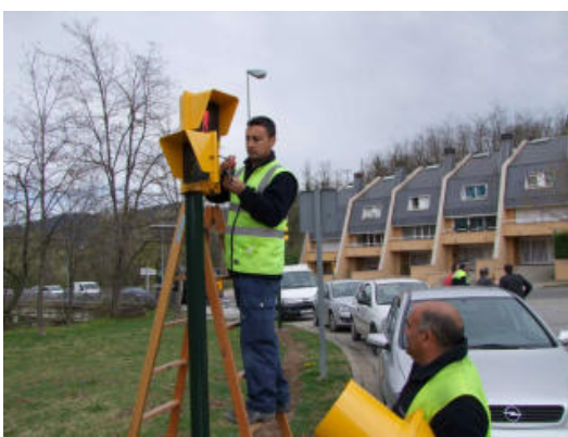
Operaris de l'empresa concessionària en la reparació d'un semàfor. <br/>
