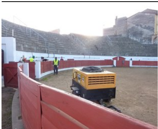
Treballs de condicionament de l'històric recinte olotí, ahir al matí. Foto: R. E.
