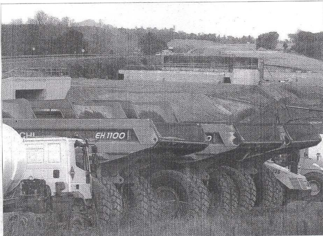
El tram de la N-II entre Caldes i Sils està en obres i està previst que entri en servei a finals d'aquest any ■ CLICK ART FOTO
