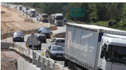
Les obres provoquen llargues cues a l'Eix Transversal, especialment en el lloc de mitja entre Osona i la Selva. Foto: JOAN SABATER.
