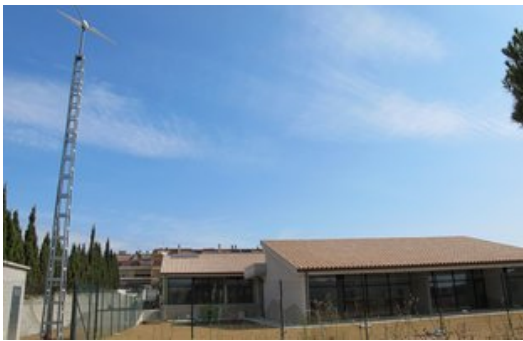
L'escola bressol inclou un aerogenerador, plaques solars i un sostre enjardinat Foto: J.SABATER.
