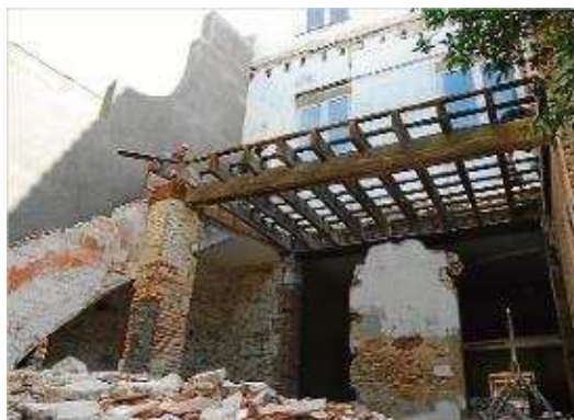
Imatge de l'estat de la reforma de l'Escola de Música. ddg
