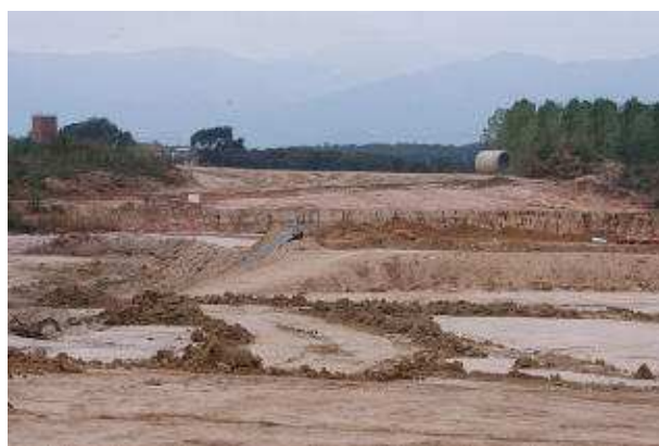
L'estat dels treballs per connectar l'Eix transversal amb la N-II a Caldes de Malavella, aquesta setmana. marc martí
