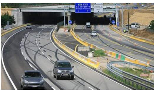
Les obres de l'autopista, ahir a l'alçada de Sant Julià de Ramis, amb els tres carrils ja acabats en direcció sud. Foto: MANEL LLADÓ.
