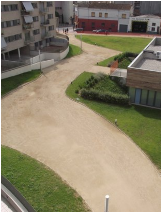
Una vista general del nou parc Pompeu Fabra que hi ha al centre de la ciutat de Banyoles. Foto: EL PUNT.
