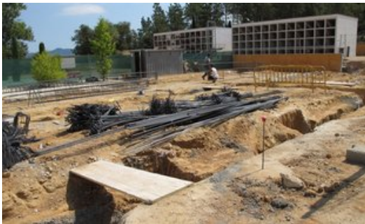
La construcció del nou tanatori dins les instal·lacions del cementiri Foto: J.N.
