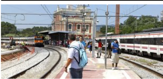
L'estació de Blanes, on s'estan fent obres de reforma. Foto: LLUÍS SERRAT.
