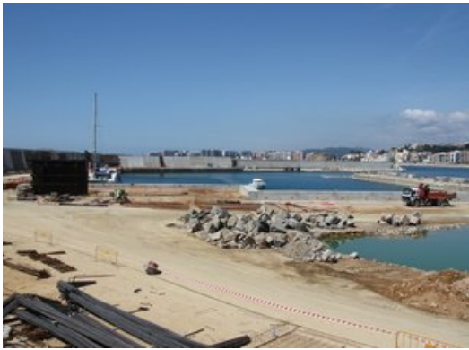
Els treballs per ampliar el port pesquer de Blanes que estarà acabat el proper mes d'octubre. Foto: ACN.
