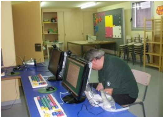
Un operari instal·lant una de les terminals en una aula de la Fundació Estany. Foto: FUNDACIÓ TELEVALL.
