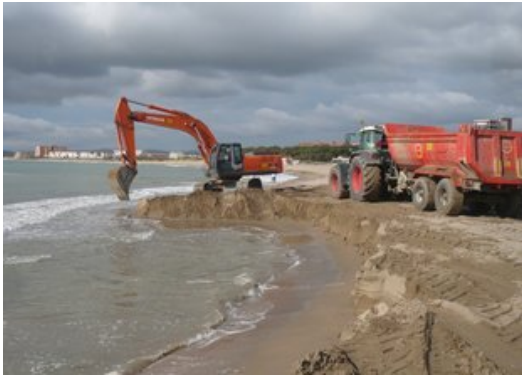
Moment de carregar sorra a l'extrem nord per portar-la als Griells, que apareix al fons. Foto: A.V.
