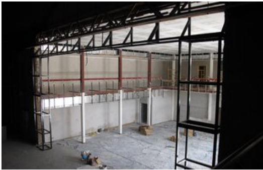
Les obres de cal Tronc , espai que s'està transformant en un centre polivalent. Foto: EL PUNT.
